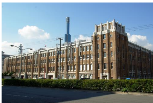
デザインクリエイティブセンター神戸（旧神戸生糸検査所）
