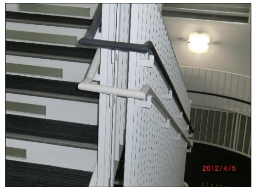
新区役所：階段二段手すり
