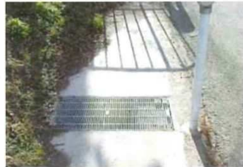
早速対応された排水設備
