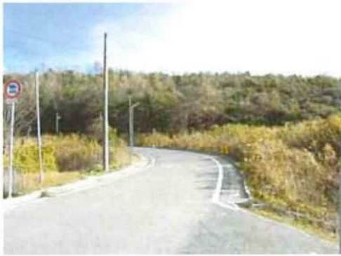
歩道のない道路
