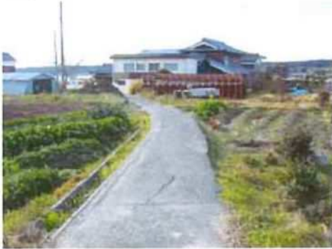
整備が望まれる道路
