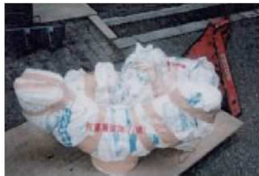
図 3.84 除去した保温材付配管を梱包、特別管理産業廃棄物として処理の例
