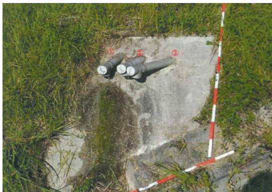
水抜きボーリング工
