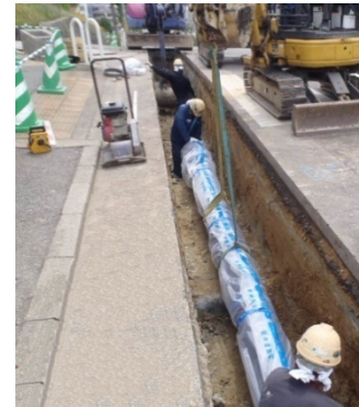
経年配水管の更新
