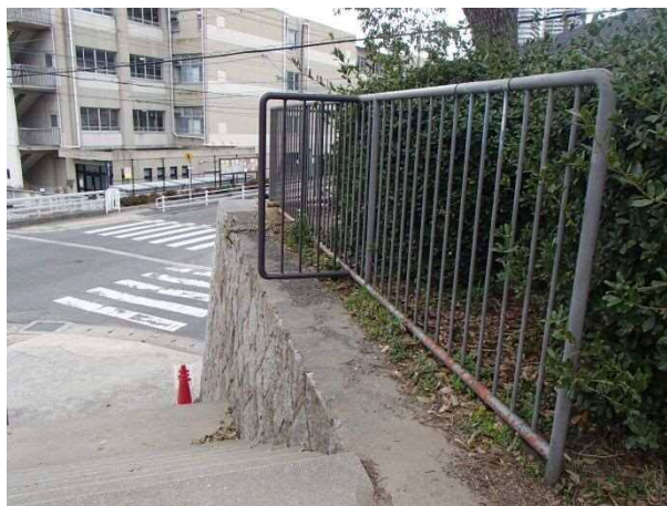
写真 8 - 1 擁壁上の柵に設けた張り出し例（灘区 大和公園）
