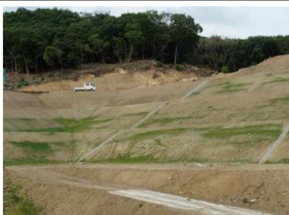
6 造成法面全景
