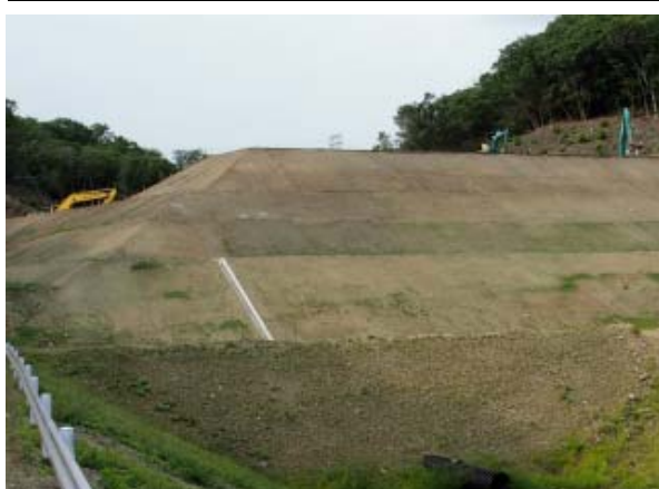
6 造成法面全景
