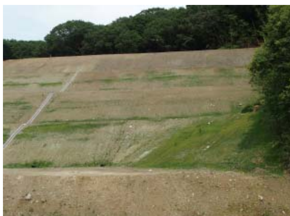
6 造成法面全景
