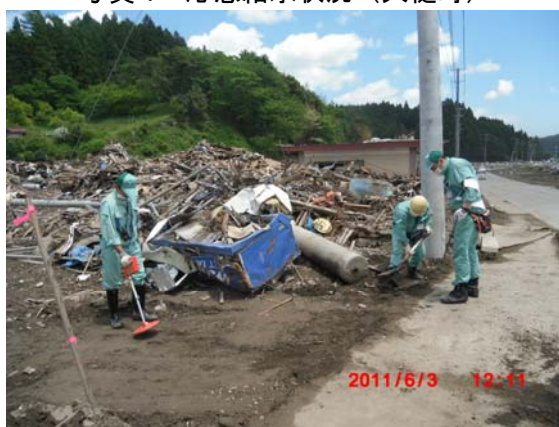
写真2 応急復旧作業状況（陸前高田市）
