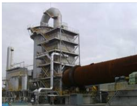
荒浜搬入場 仮設焼却炉
