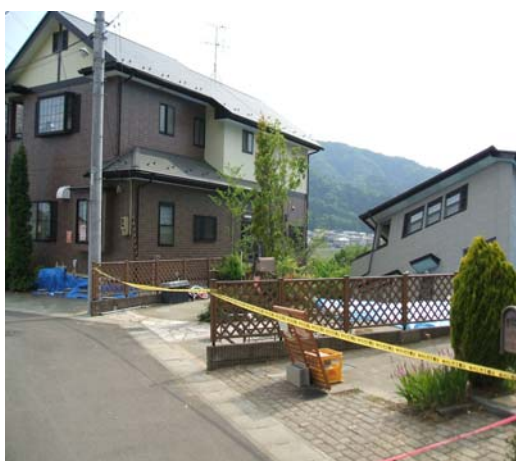
地すべりエリアの被災状況
