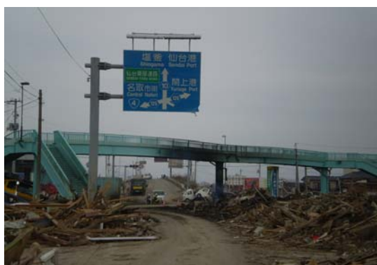
宮城県道(10号塩釜亙理線)の道路啓開
