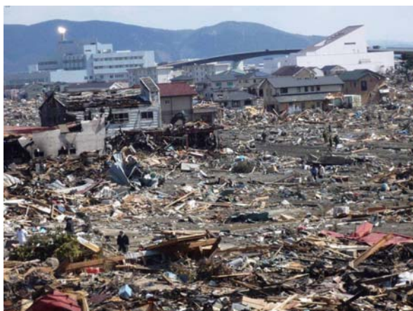
写真 4 : 石巻市内 : 壊滅した石巻市民病院
