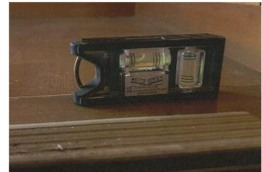
建物の傾き状況を水平器で測定
