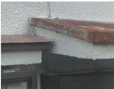
庇材の腐食
