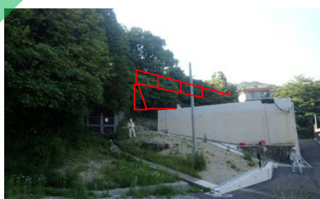
赤塚山特1高層配水場【令和元年度施工予定】
