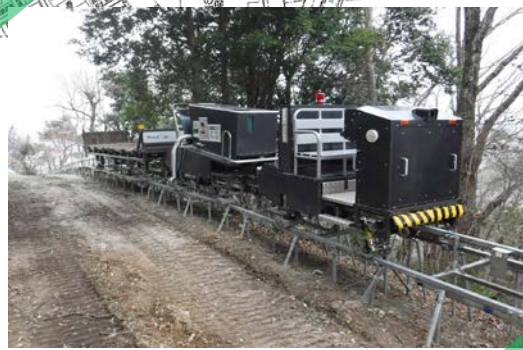
工事用モノレール
