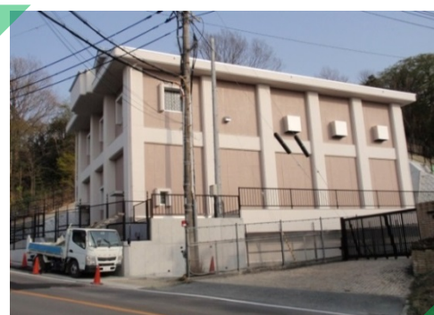
有野ポンプ場(令和元年度ポンプ設備新設予定)
