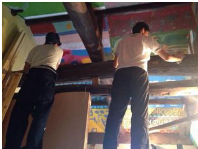
長田区駒ヶ林町における古民家再生
