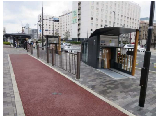
写真. 地上に設置された出入口(京都駅)
