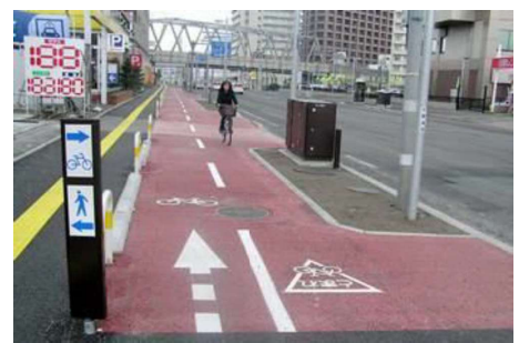
写真、自転車走行位置・ルール周知を示す路面表示（札幌市）
