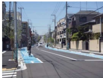
写真 車道上の自転車レーン (自転車専用通行帯)
