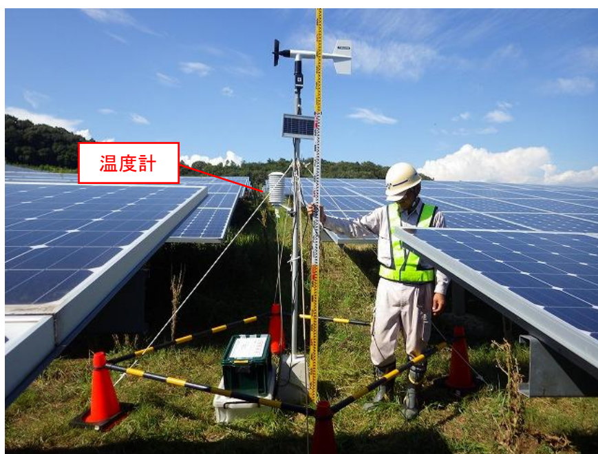
写真 12.13-1 地点 A の調査状況
