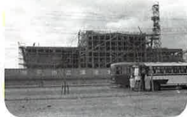
建設中の須磨水族館 昭和31年
