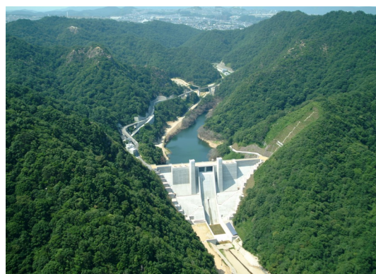
<洪水調整池：石井ダム >
