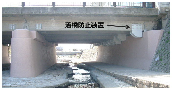
<橋脚の耐震補強と落橋対策>
