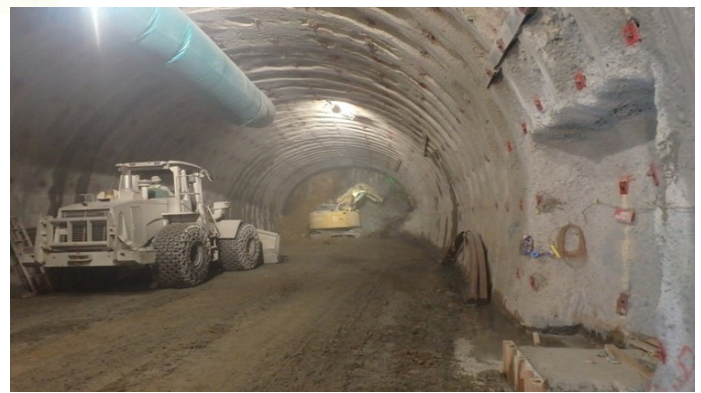
<県道 神戸三田線 有馬口トンネル>
