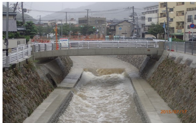
<妙法寺川 河道拡幅と橋梁架替>
