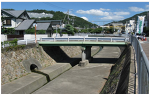
<妙法寺川 河道拡幅と橋梁架替>
