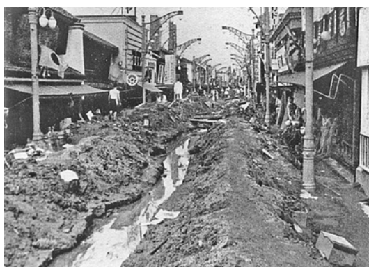
泥土の山となった元町通
