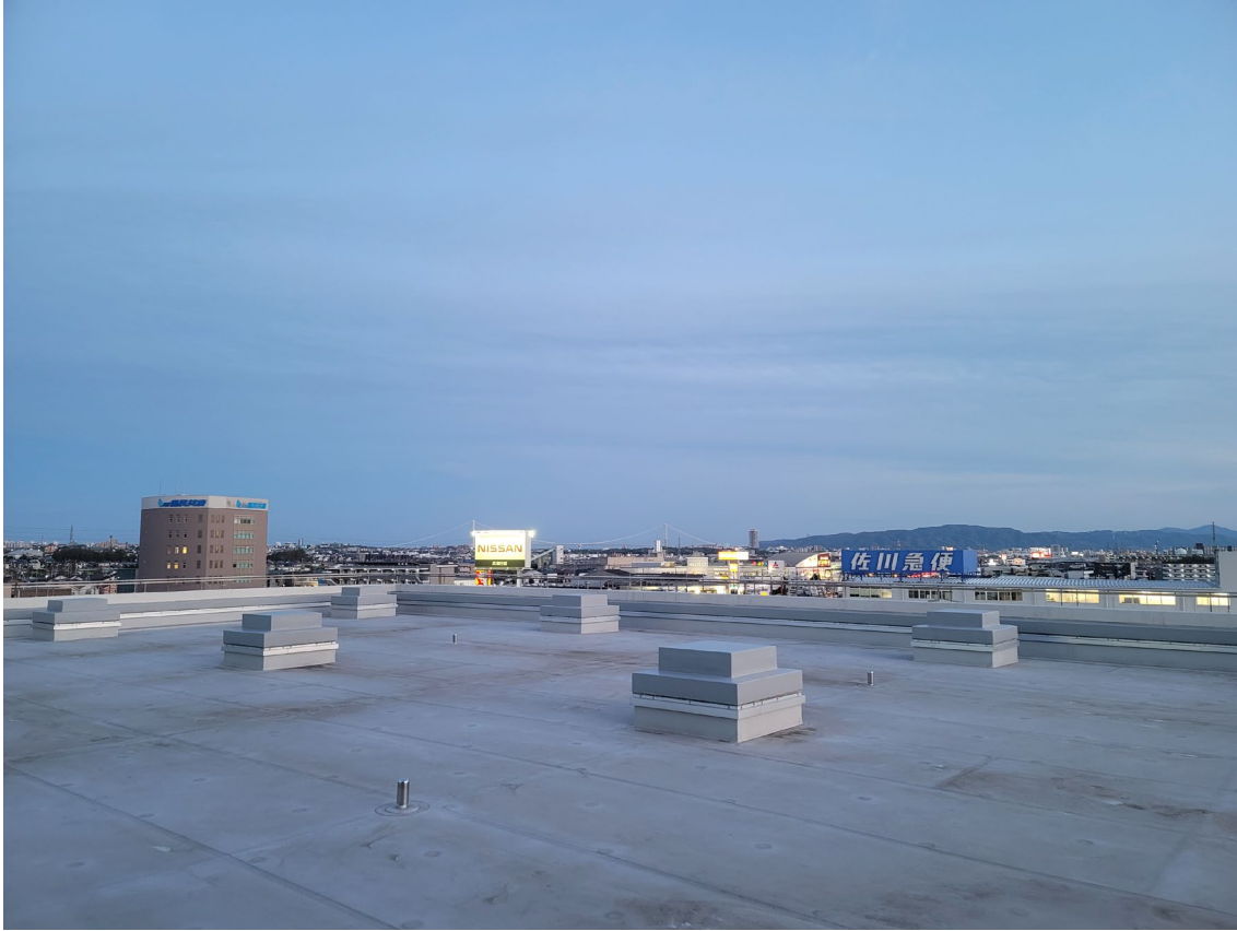
屋上 明石海峡方面
