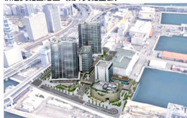
新港突堤西地区（第1突堤基部）
