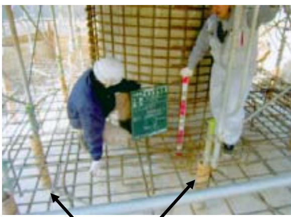
基礎フーチング増し打ち部の足場の箱抜き
