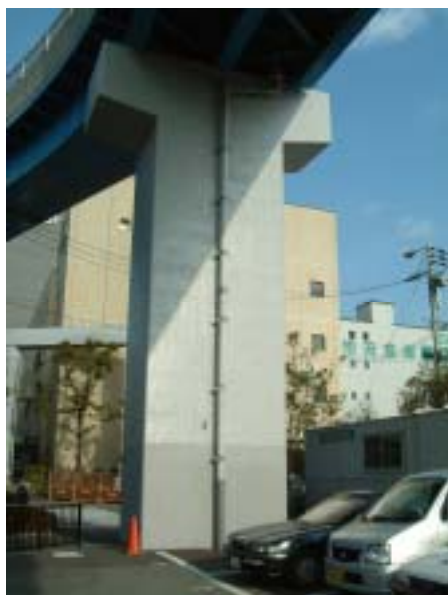
ひびわれ補修後
