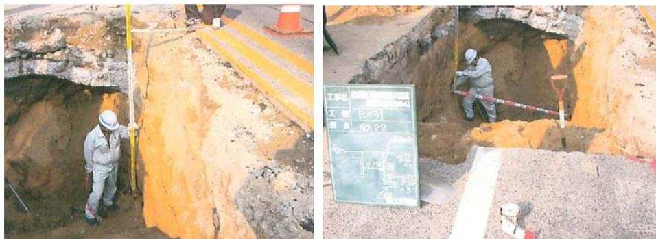
土留工のない試掘（掘削深約 3 m）
