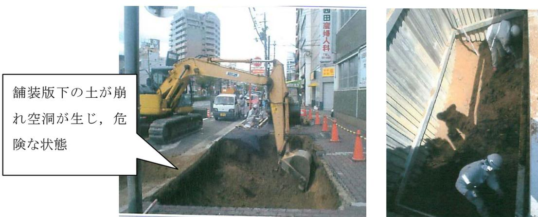
舗装版下の土が崩れ空洞が生じ、危険な状態
