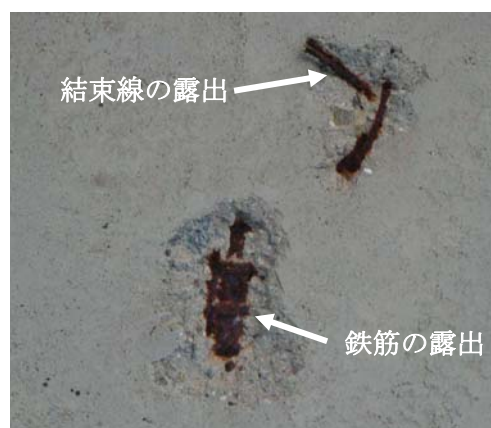
「かぶり」が 5mm 程度しかなく、鉄筋の腐食によってコンクリートが剥離している状況
