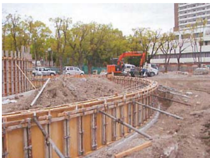
型枠設置状況 (ウォール工-3)
