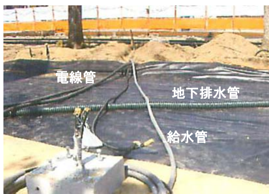
防水シート上の配管 （施設土工は不要）
