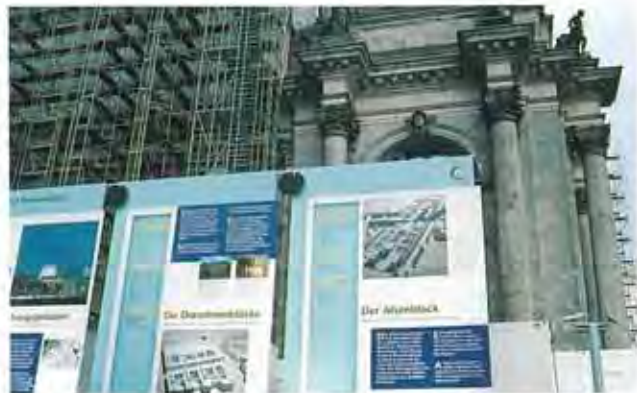
建物の修復時には、その過程や将来の姿を広く見せることが重要です。
