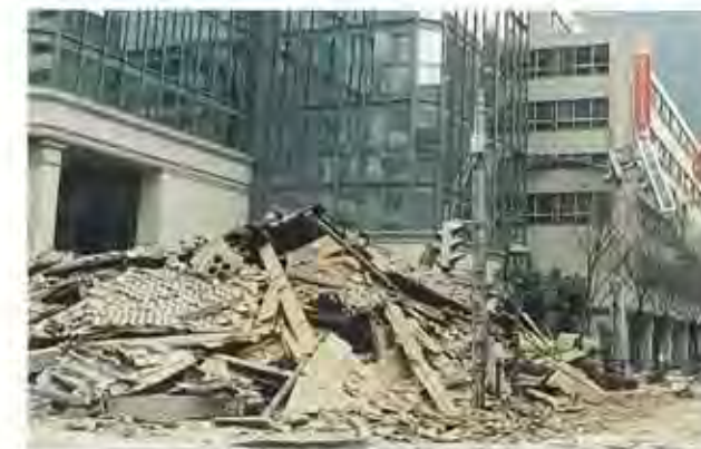
阪神・淡路大震災による被害 (居留地時代から唯一残されていた15番館は全壊した)
