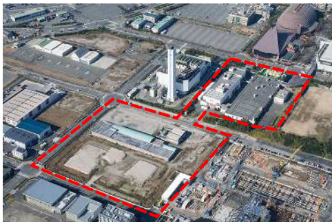
ポートアイランド処理場
