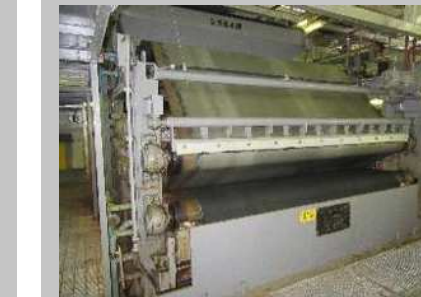
■汚泥脱水機 Dewatering machines 汚泥に凝集剤を加え、脱水します。固形物を脱水ケーキとして取り出します。
