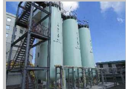
■ガスホルダ Gas holders ガス発電や給湯ボイラに使用する精製ガスを貯蔵します。
