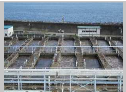
■反応タンク Reactors 最初沈殿池から出てきた汚水に、活性汚泥（返送汚泥）を加え、空気を吹き込み、微生物の働きで汚れを分解します。
