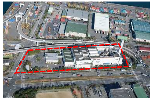
東部スラッジセンター
