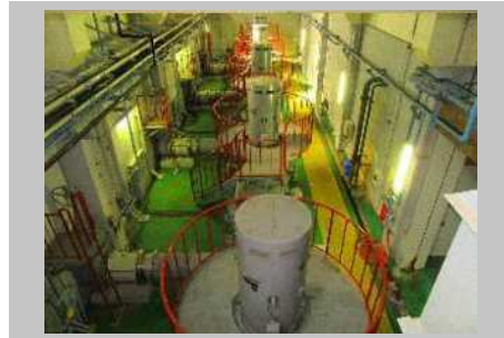
■汚水ポンプ Sanitary sewage pumps 地中深く到達した汚水を地上へくみ上げ、その後は自然の流れで処理が進みます。
