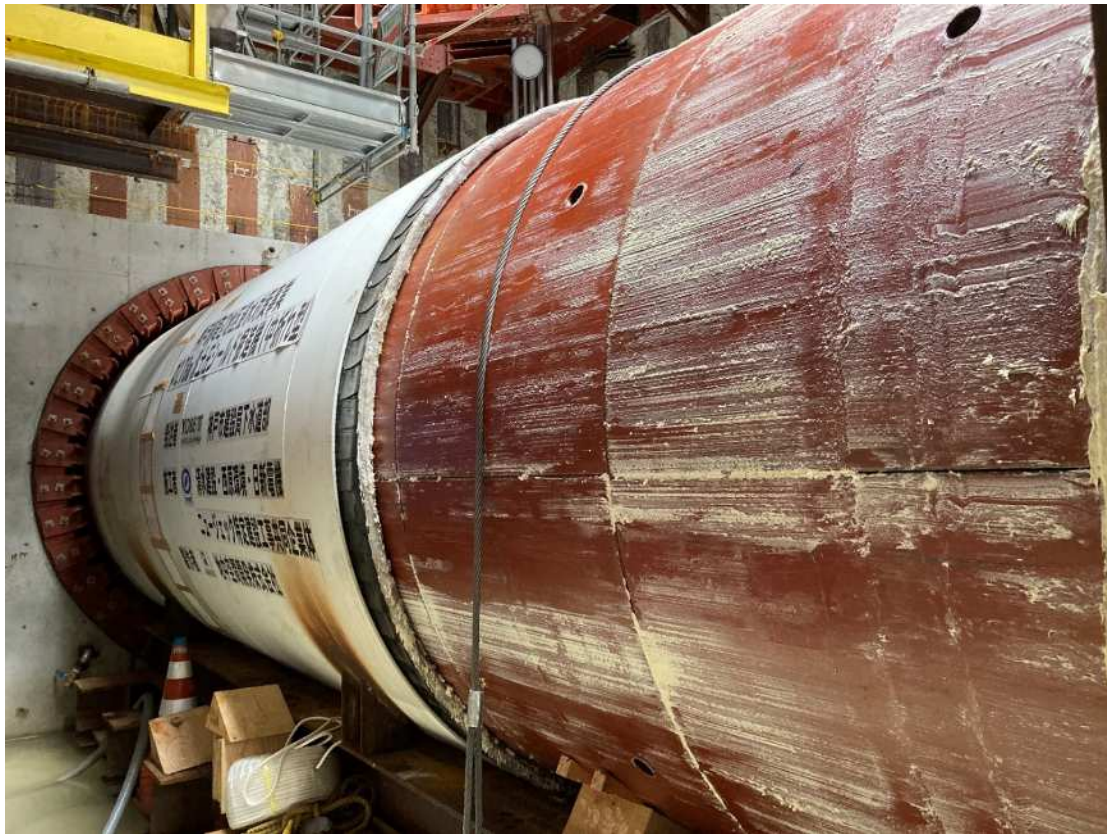
④雨水幹線工事のためのシールドマシンが発進
