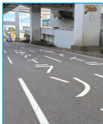
⑳ 第二工区内道路 (改修後)
