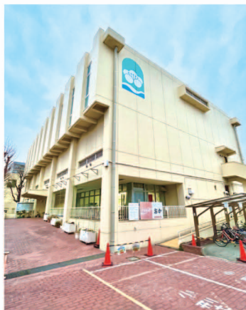
築46年が経過した東灘体育館
