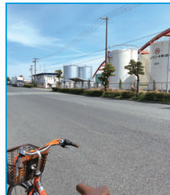
⑳ 灘浜住吉川線 (補修前)
