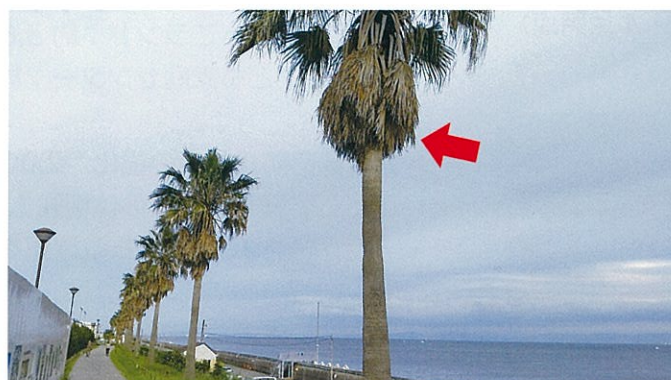
改善前（葉が枯れて危険な状態でした）
