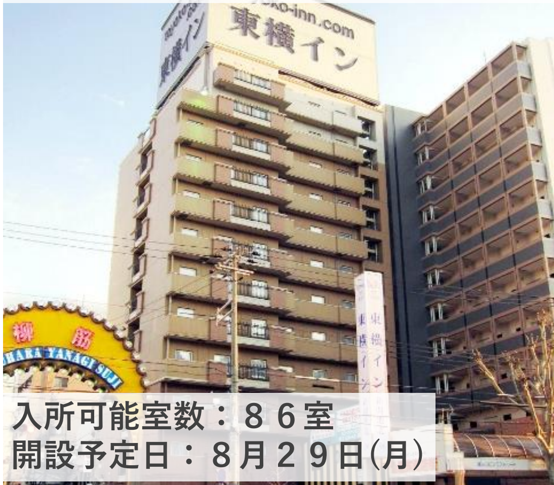
東横INN神戸湊川公園 (兵庫区)
