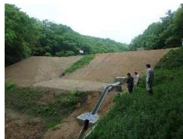
ため池改修工事
