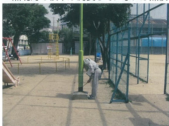
■照明灯の根本が腐食していないか点検
