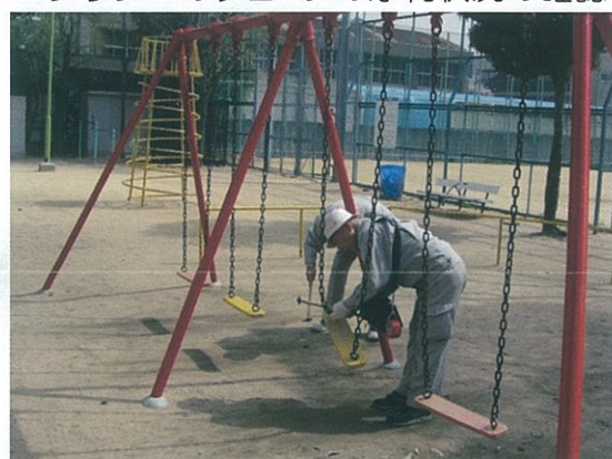
■ブランコのチェーンの摩耗状況の確認
