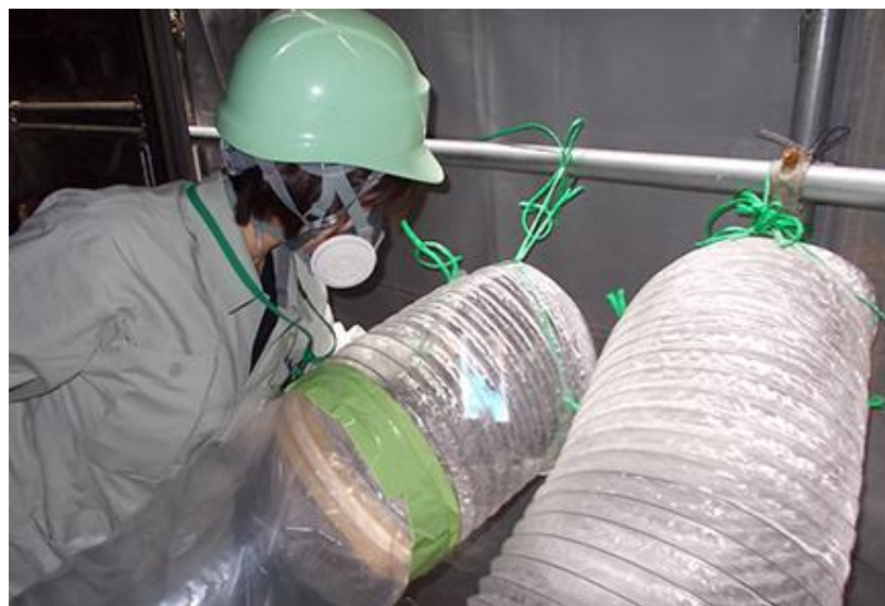
解体工事におけるアスベスト測定
