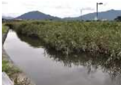
St⑤. 荒井中央幹線排水路:圃場整備時に出来た中央承水路. 幅6~8mのコンクリート護岸. 河口域には泥が堆積, 上流域は砂礫土砂が堆積する.
