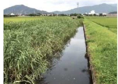
St⑧. 西部幹線排水路:美浜町水田の西部幹線承水路. 久々子漁協船置き場に注ぐ幅8mのコンクリート護岸排水路. 底質は泥質から砂礫状. 右岸にはヨシが繁茂する.
