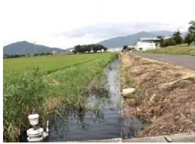
St⑦. 美浜体育館北排水路:美浜町総合運動公園脇の水田排水路. 幅2mのアーム柵護岸. 底床には泥が堆積する. 増水時には流速が速い.
