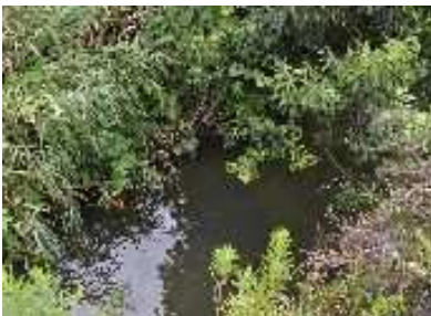
St②. 宇波西川下流域:久々子湖に流入する宇波西川の河口域. 幅6~8mのコンクリート護岸三面張り河川. 上流域は砂礫が堆積している.
