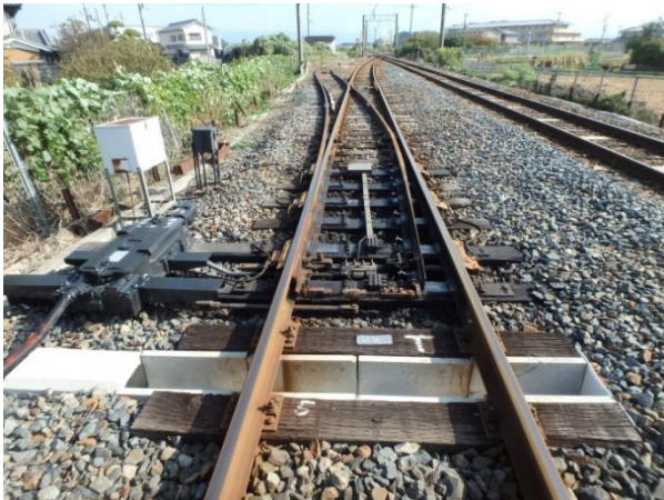
図7. 営業線ポイントへのU字溝設置状態
