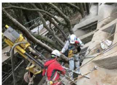
【立会状況(現場側)】
