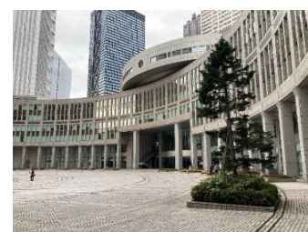
東京都庁舎 都民広場 (平成 2 年 (1990 年) 竣工)
