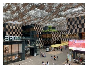
アオーレ長岡の「ナカドマ」 (平成24年(2012年)竣工)
