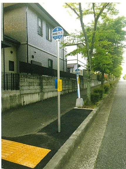
バス停留所の標柱の埋め込みや点字タイルの設置がすすむ
