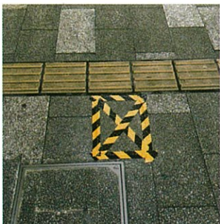
印のところの改修が終わりました
