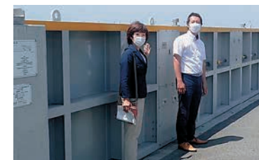
高潮対策前進 沿岸部に 防潮鉄扉(六甲アイランド)
