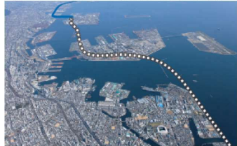
<未開通区間の事例 大阪湾岸道路（西仲部）>
