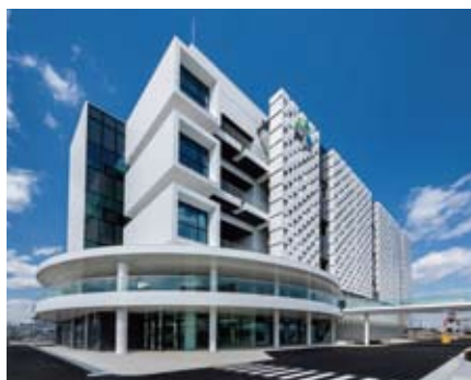
神戸ポートライナー「京コンピュータ前」駅の北側に位置する神戸医療イノベーションセンター
