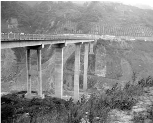
写真-23 被災を受けていない寿江大橋の橋脚： 汶川県映秀鎮～都江堰市
