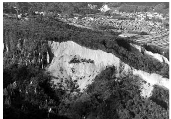
写真-4 1995年の段丘面の崩壊（西宮市船坂）
