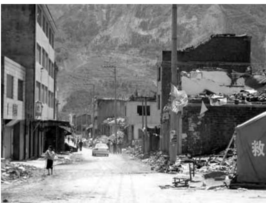
写真-17 山地内の平坦面上で破壊した建物：北川県擂鼓鎮
