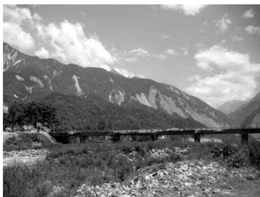
写真－6 彭州市龍門山鎮近くの斜面崩壊（橋梁は通行止め）
