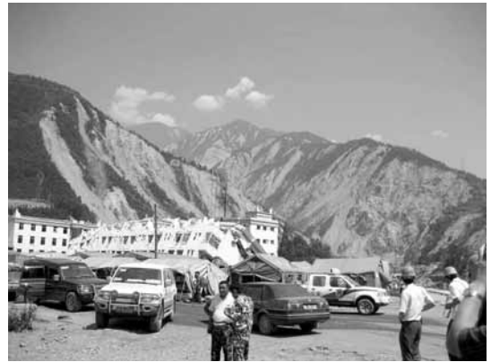
写真-18 全壊に近い建物と周囲の山腹崩壊：汶川県映秀鎮
