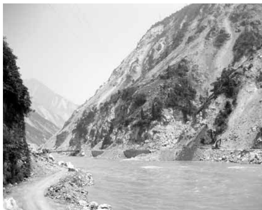
写真-20 復旧工事中の岷江沿いの道路：汶川県映秀鎮
