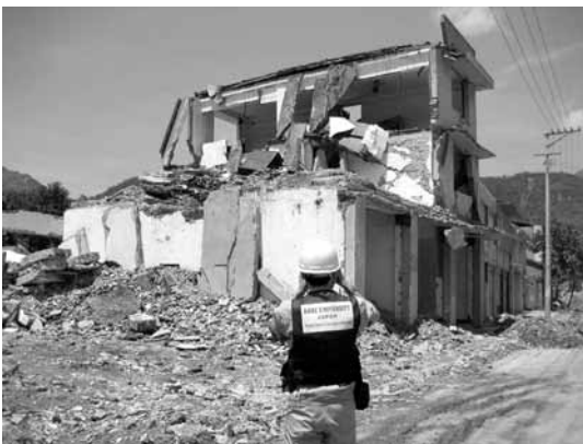
写真-16 二階が大きく壊れた建物：北川県擂鼓鎮
