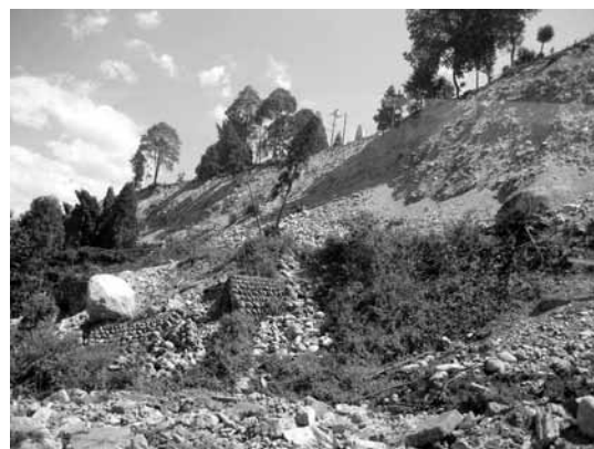
写真－7 段丘崖の崩壊：彭州市龍門山鎮
