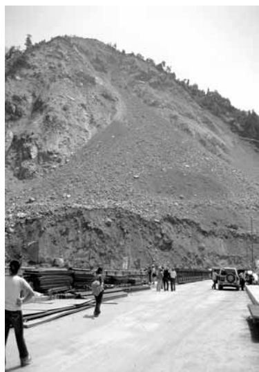
写真-21 道路復旧のためのテラス斜面裾部の切り取り：汶川県映秀鎮
