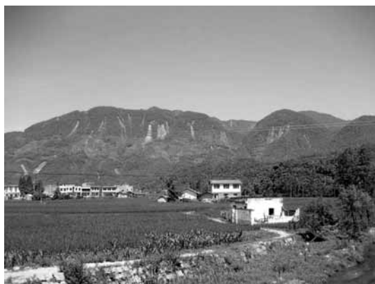
写真－5 急斜面の崩壊（緩斜面は崩壊なし）：安県
