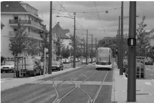
写真-6 景観向上・環境改善に貢献する芝生軌道 (仏・ストラスブール)
