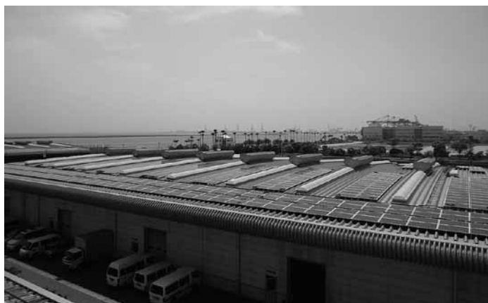
神戸港太陽光発電所
