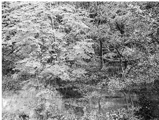
施工後緑が回復した斜面对策状況（北畑地区）
