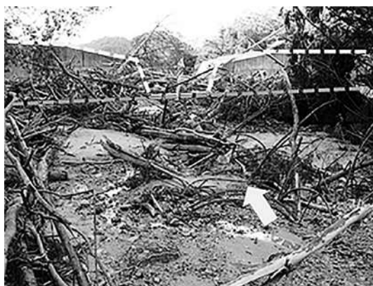
災害後土砂捕捉状況（東船坂えん堤）
