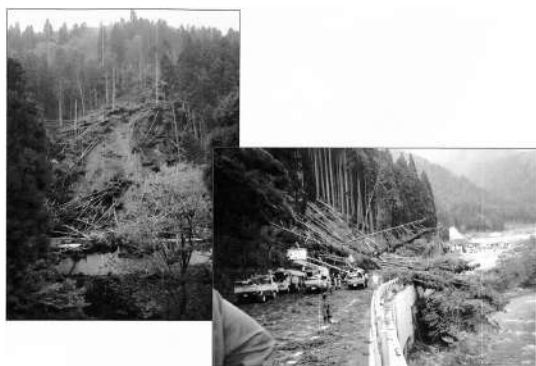
国道沿いの斜面崩壊
