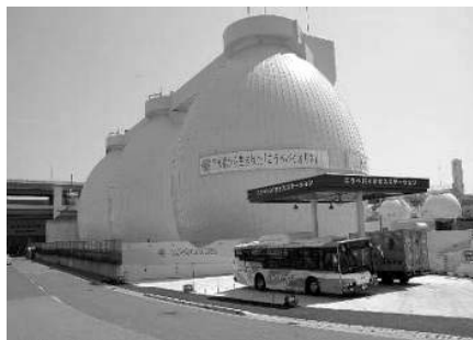
写真2：こうべバイオガスステーション
