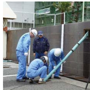
・防潮堤鉄扉閉鎖作業
