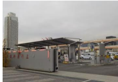
防潮鉄扉@新港第一突堤
