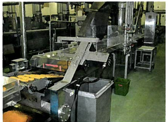
工場3階 揚物生産設備
