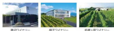
※PPAは、「Power Purchase Agreement (電力販売契約) モデル」の総称で、電気を利用者に売る電力事業者 (PPA事業者) と電力の使用者と間で結ぶ「電力販売契約」のことを示します。キリンビールでは、三菱商事エネルギー・ソリューションズ株式会社の子会社であるKCSエネルギーサービス株式会社がPPA事業者となり、ビール工場の屋根にメガワット級の太陽光発電設備を設置し、その発電電力をキリンビールが購入・活用することで実現しています。
